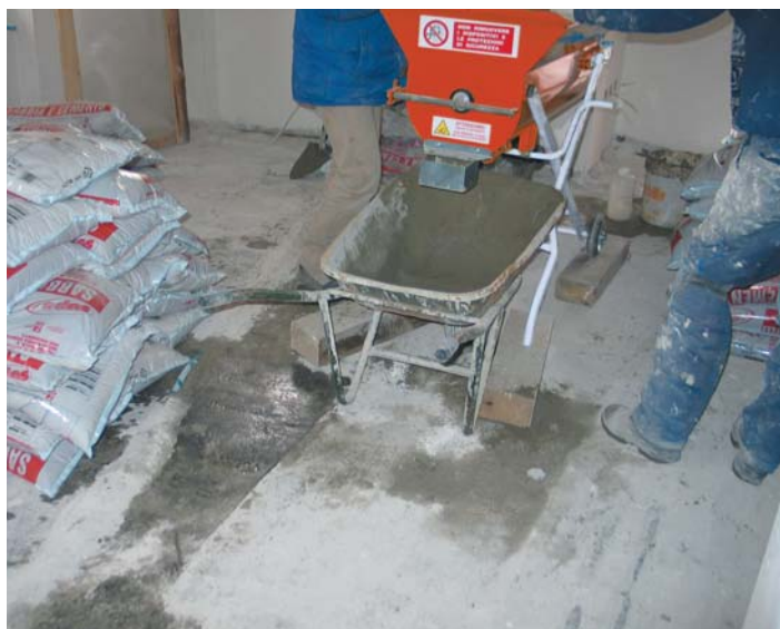
Mischung von SUPER SABBIA E CEMENTO FIBRORINFORZATO mit TURBOMALT EVOLUTION.
