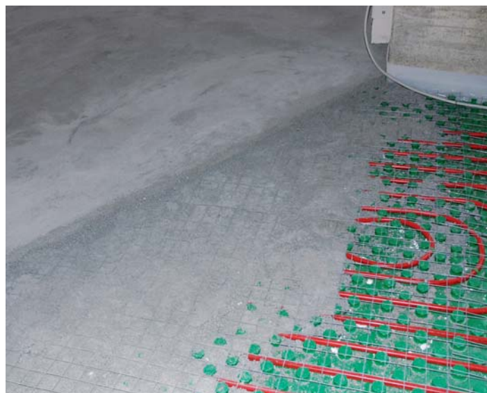
Verlegung von SUPER SABBIA E CEMENTO FIBRORINFORZATO für die Herstellung von Bodenheizungsplatten.
