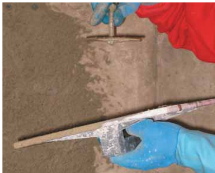
Intonaco eseguito su parete in calcestruzzo con MALTA DI CEMENTO.
