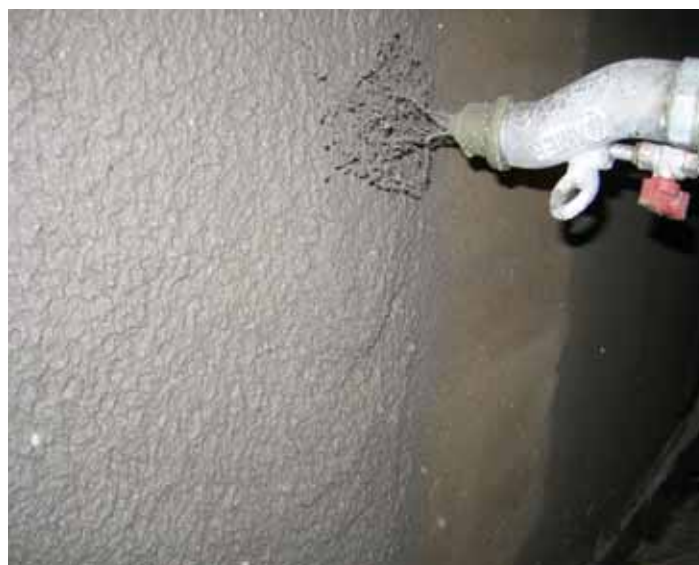
MALTA DI CEMENTO può essere pompata con idonea pompa (tipo Step 120 di IMER International).
