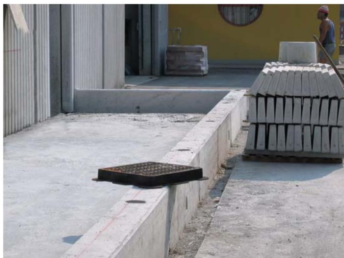
Herstellung von Einzäunungsmauern mit BETONRAPID. Die Schnelligkeit der Härtung ermöglicht einen fast sofortigen Einsatz des Artefakts.
